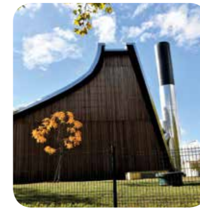
Chaudière bois du quartier des Couronneries à Poitiers
