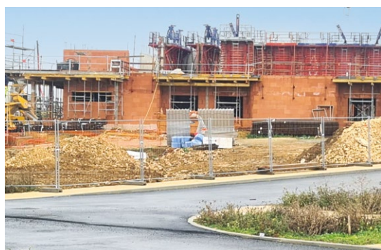
Chantier de la Vallée Mouton © Emmanuel Guillou
